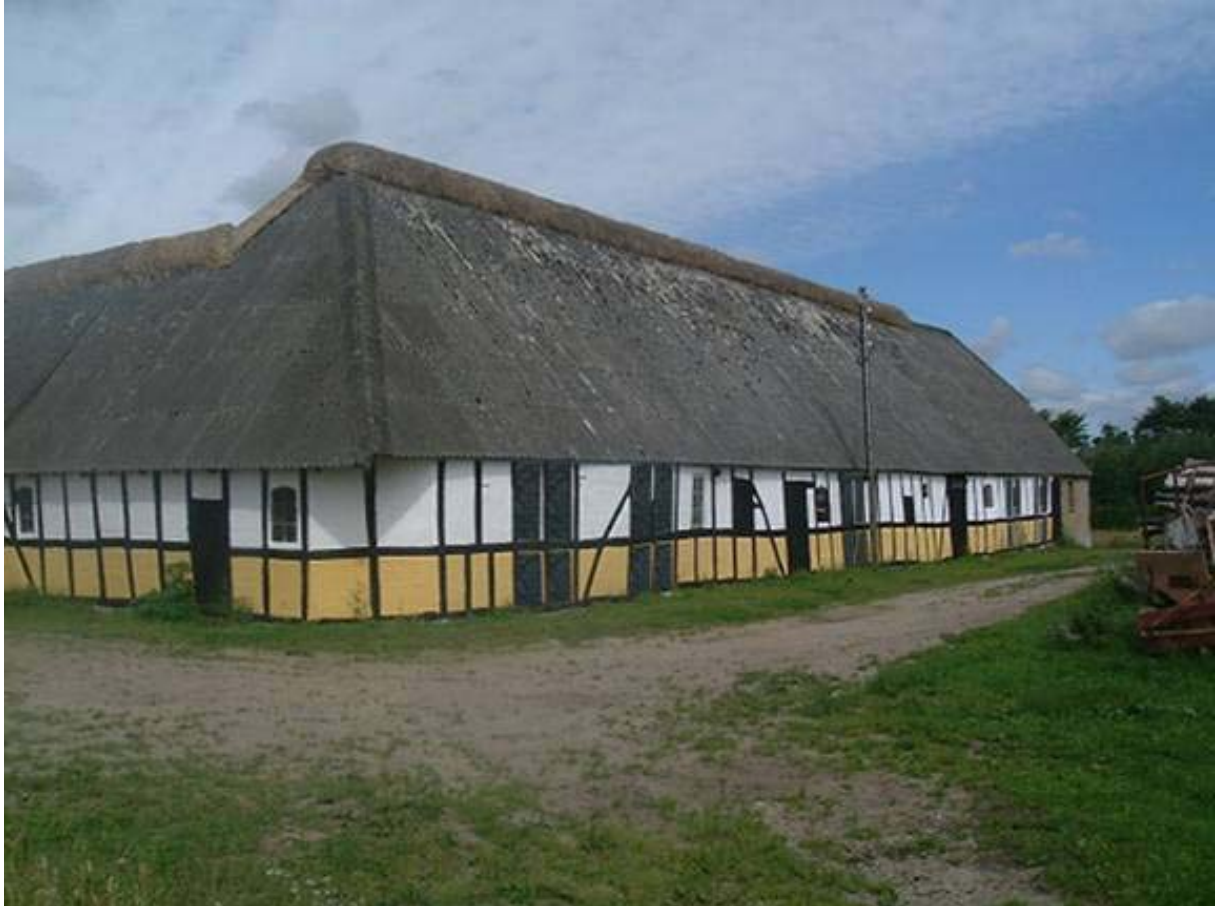
Østlængen hvor tavl er erstattet med ifuget glas
