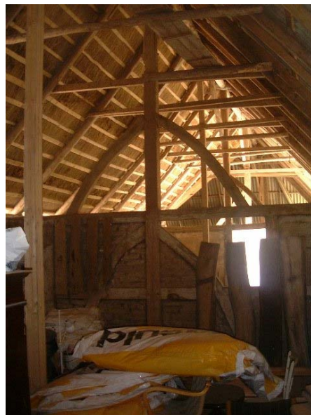
Sydlængen med sulekonstruktion
